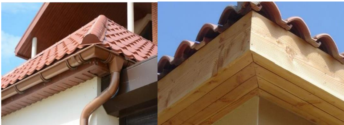
Photos de planche à rive sur les maisons
