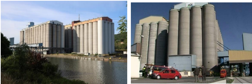
Photos des silos à grains au port de Frouard
